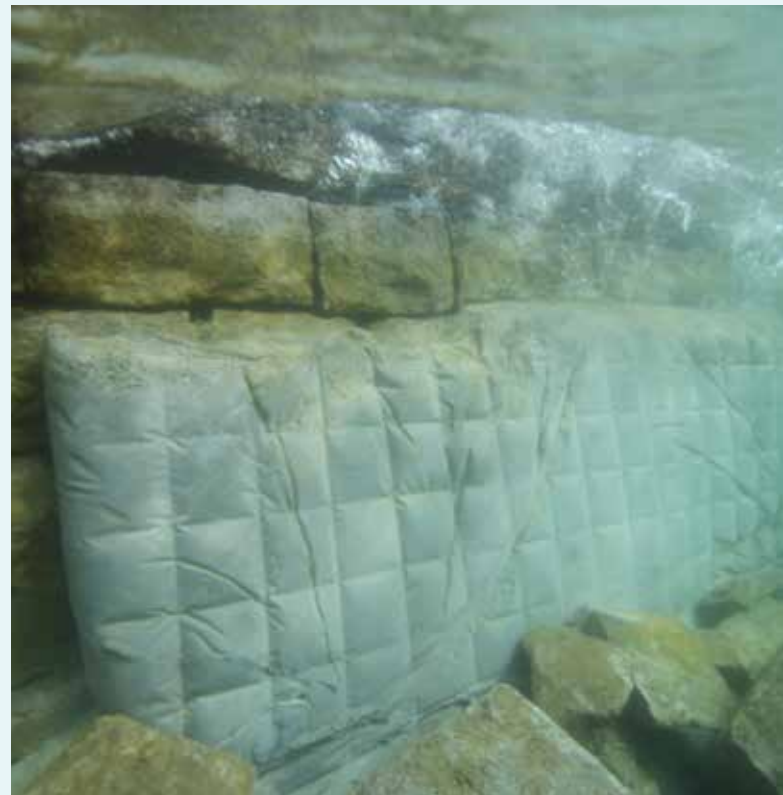
Après réfection de berge
